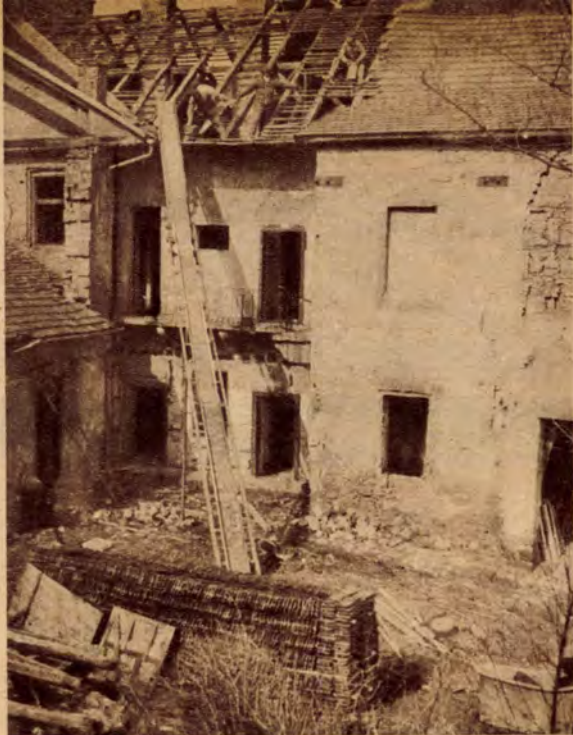
Az anyagdepóniákat a bontandó épülettől távol kell elhelyezni, nehogy a lehulló kövek kárt okozzanak
